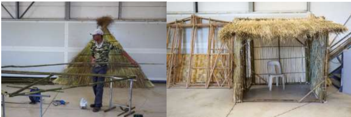
Fig. 22 : Richard Patterson réalisant une structure en bambous et vétiver pour un le toit d'un restaurant de bord de mer, 2024.
