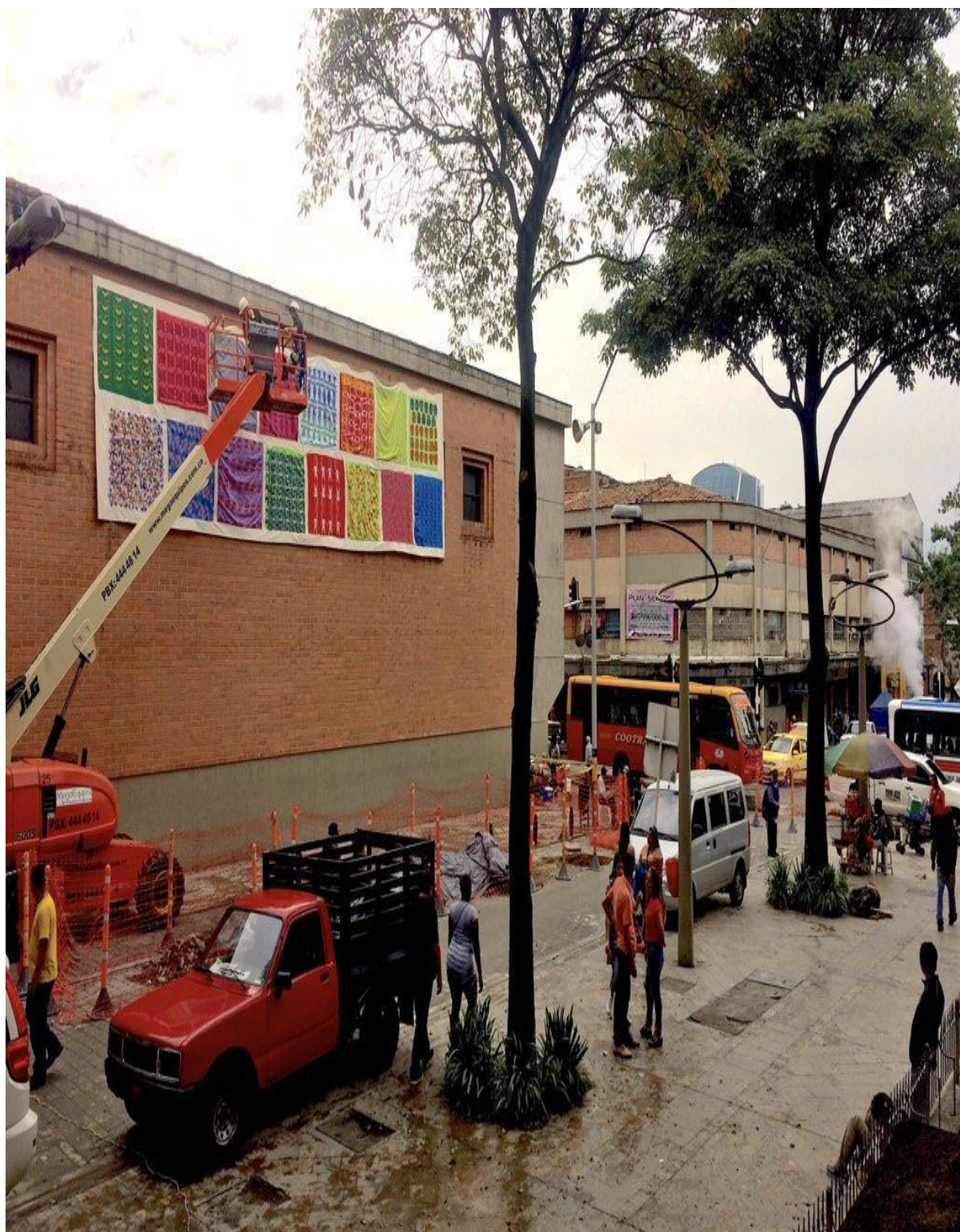
Figura 1. Instalación de resultado del proyecto Nosotras por nosotras en la fachada lateral de la sede alterna del Museo de Antioquia. (Foto: Carolina Chacón, 2016)
